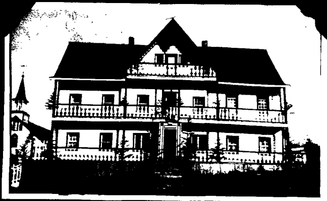
L'ancienne résidence des RR.PP.OBLATS démolie en 1956.
