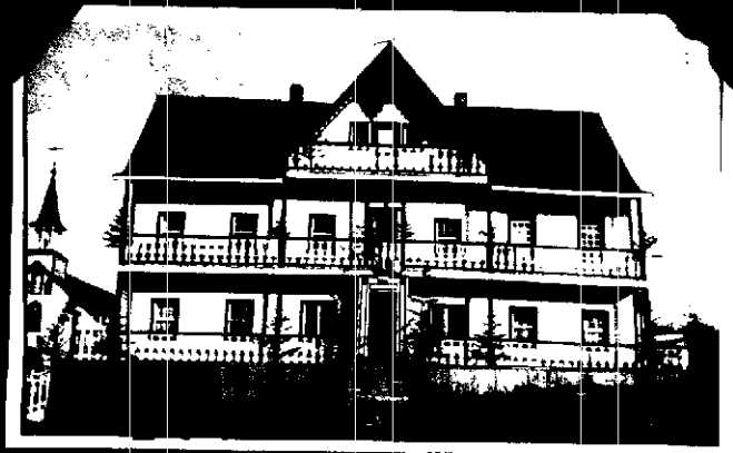
L'ancienne résidence des RR.PP.OBLATS démolie en 1956.
